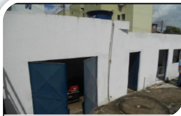
Sala de Comando de Distribuição
