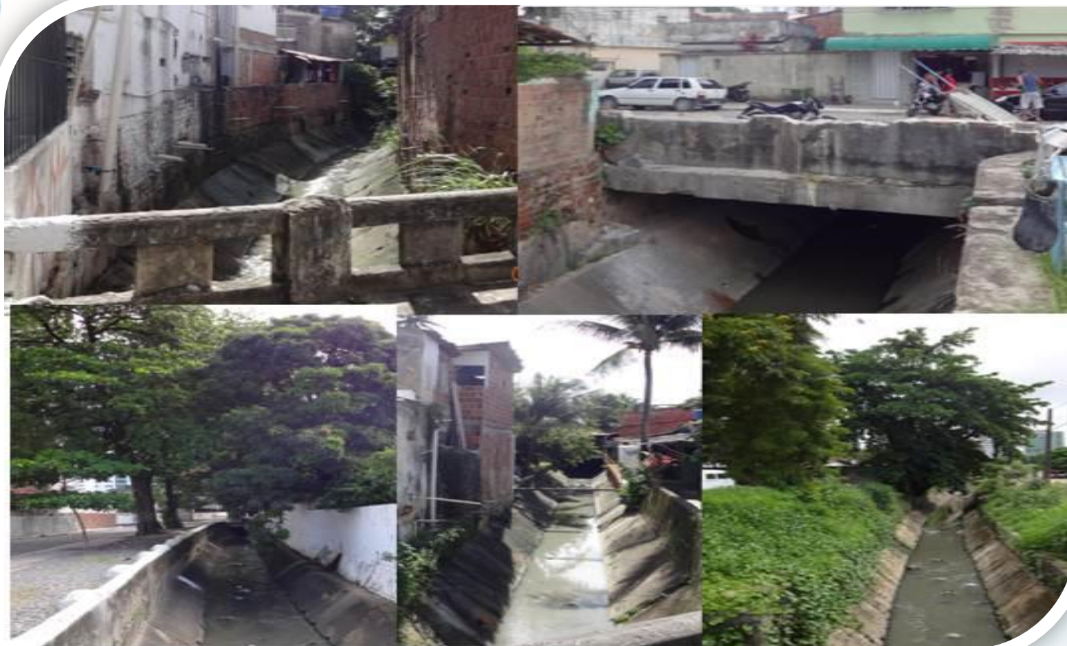
Vistas parciais do Canal Vasco da Gama-Arruda no bairro da Casa Amarela
