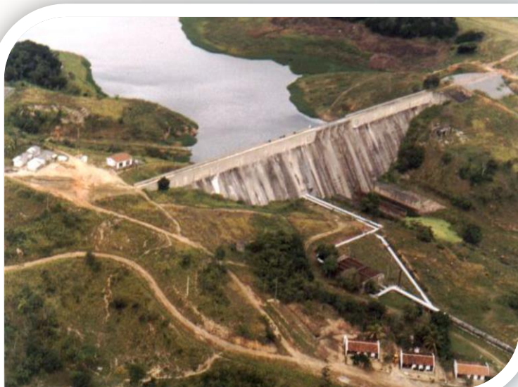
Barragem do Tapacurá
