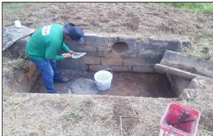
Figura 64: Atividades de manutenção do aterro encerrado da Muribeca: manutenção da caixa de passagem
