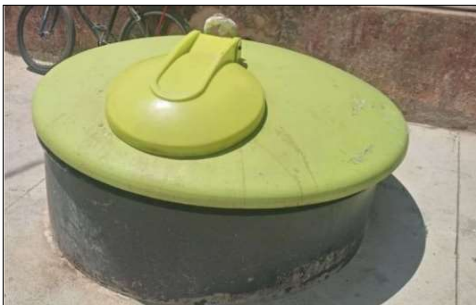
Figura 35: Contentor semienterrado/Recife – PE
