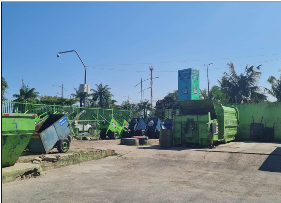
Figura 41: Estrutura e equipamentos na Ecoestação Agamenon
