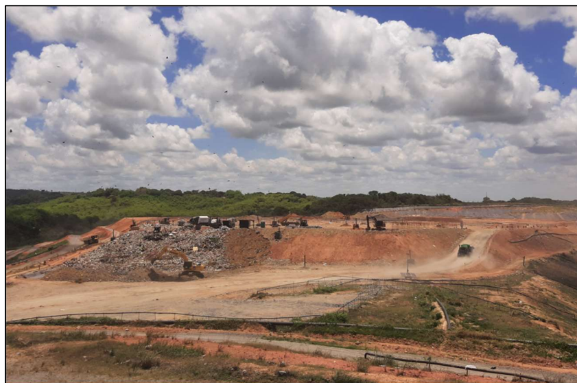
Figura 46: Frente de trabalho do aterro sanitário
