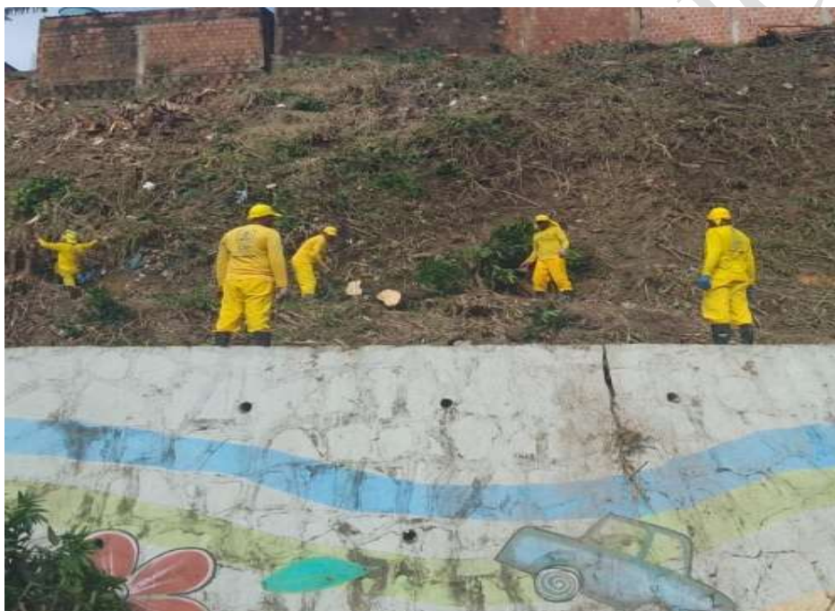
Figura 16: Execução de serviços de manutenção em Recife – PE
